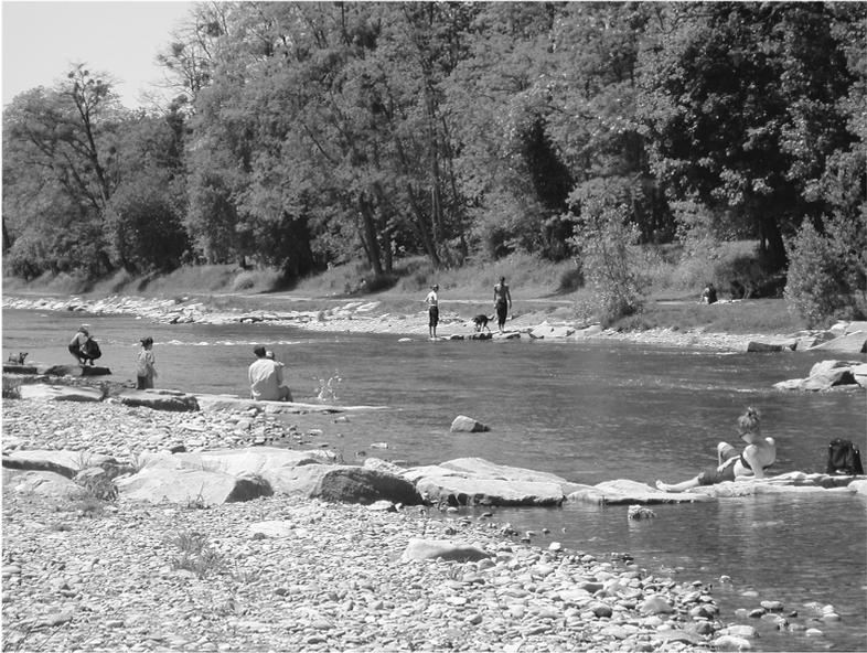
**Abb. 2:** Pilotstrecke für die Revitalisierung der Wiese in Basel. Innerhalb der bestehenden Hochwasserdämme konnte maximal eine Verdoppelung der Flussbreite erreicht werden. Im Fluss entstehen dadurch vielfältige Strömungsverhältnisse sowie flachere und tiefere Bereiche. Grosse Veränderungen wie in einer natürlichen Flusslandschaft sind aber nicht möglich.
