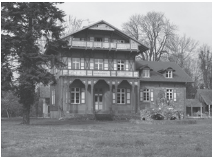
Die Gebäude der ehemaligen Fischzucht bilden das Zentrum der Petite Camargue Alsacienne.
