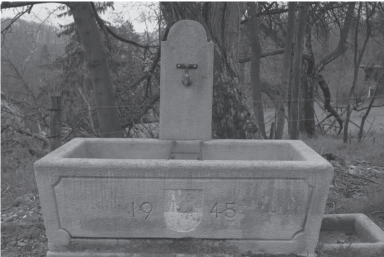
Feldbrunnen in Therwil, dessen Wasser aus Quellen in unmittelbarer Nachbarschaft im Gebiet Grüt stammt.
