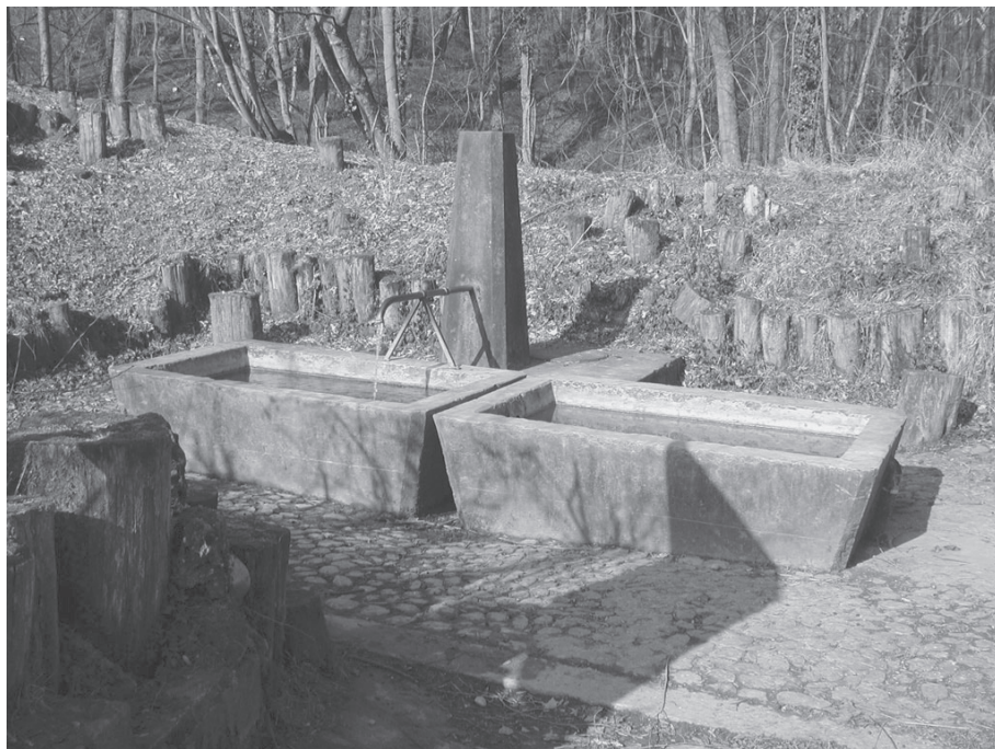
Der Waldbrunnen in der Herzogenmatt in Biningen wird ebenfalls direkt von einer gefassten Quellen gespeist.
