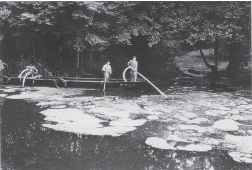
Absaugen von Faulschlamm an der Ergolzöffnung im Jahr 1959
