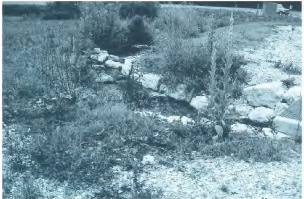
Abb. 9: Umgehungsgerinne an der Birs. Im Gegensatz zu einer Fischtreppe fügt sich ein Umgehungsgerinne optimal in die Landschaft ein und dient den Fischen auch als Lebensraum.
